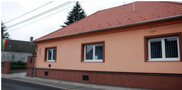
Bazsi Faluház külső homlokzata
